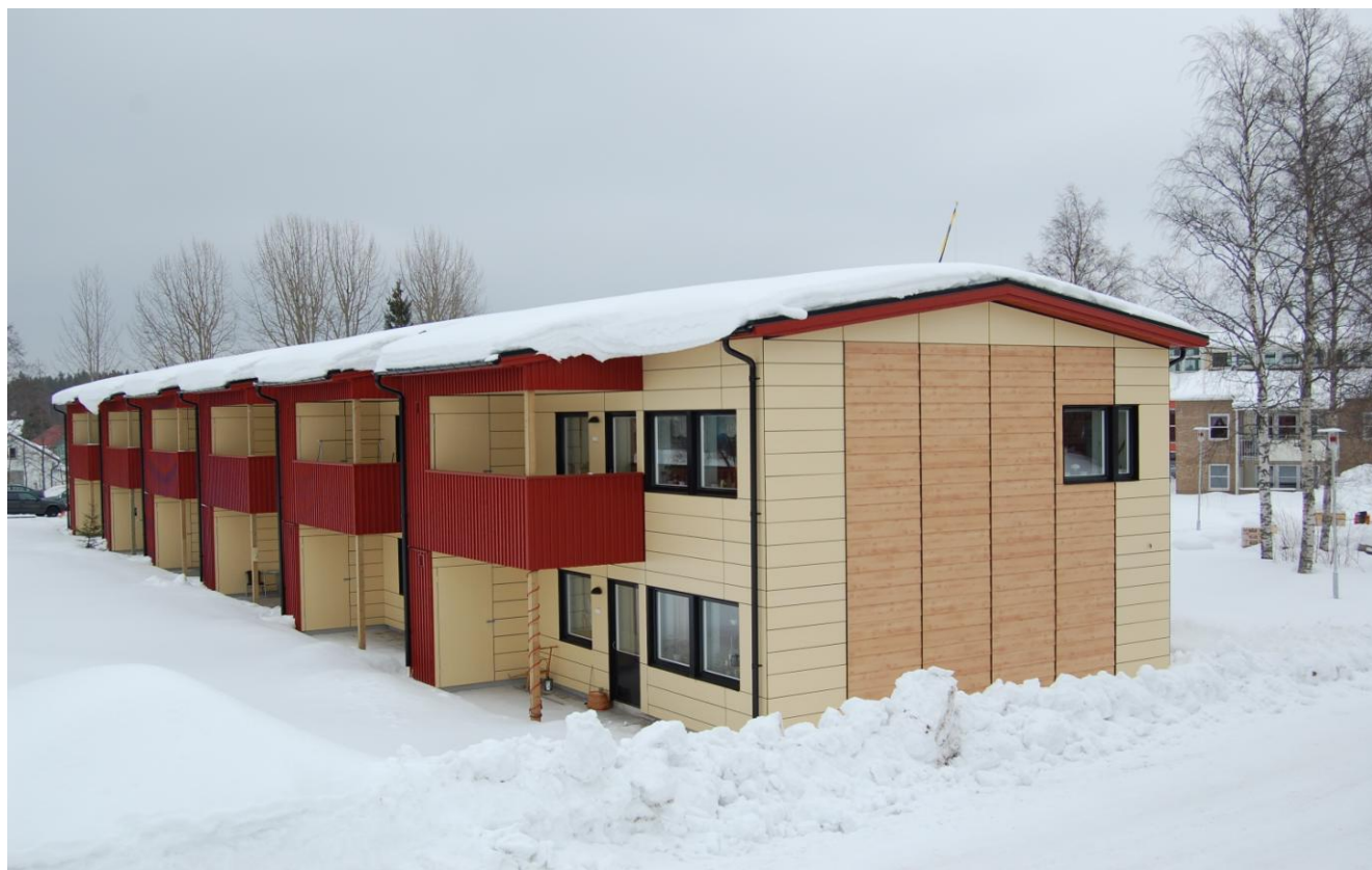
Kullenuthbyggnationen med 12 st. lgh i Nordmaling, inflyttningsklara 1 december 2010.
