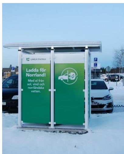
Invigning laddcentral vid Resecentrum
