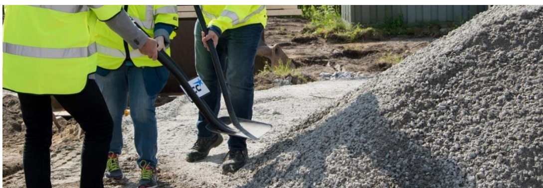
Första spadtaget till nya hyreshuset, Nordmalingshus AB
