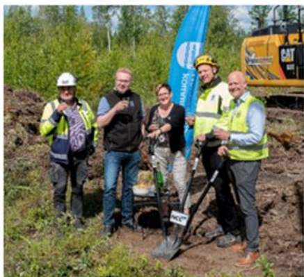
Första spadtaget vid omlastningscentralen i Rundvik.
