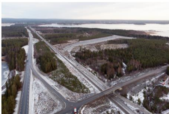
Översiktsbild över omlastningscentralen i Rundvik.
